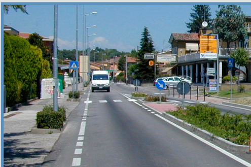
Ponti sul Mincio, attraversamento con isola spartitraffico
