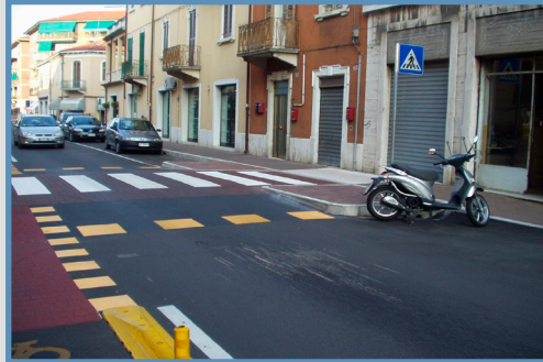
Verona, attraversamento avanzato e rialzato
