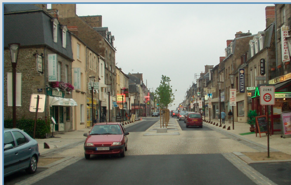
Zona 30, cambio di pavimentazione e fascia centrale alberata
