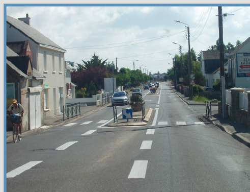
Fascia centrale delimitata con segnaletica
