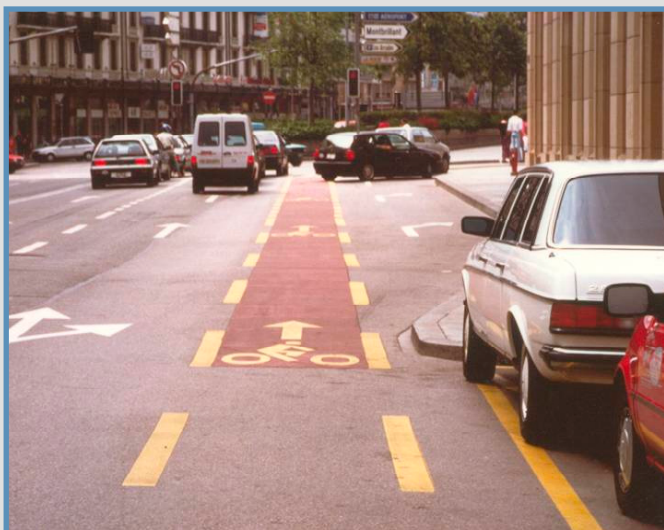
Francia, situazione ottimale, la corsia ciclabile viene maggiormente evidenziata per dare sicurezza e visibilità alla componente ciclabile che prosegue dritta. A lato schema funzionale tratto da pubblicazione del Certu
