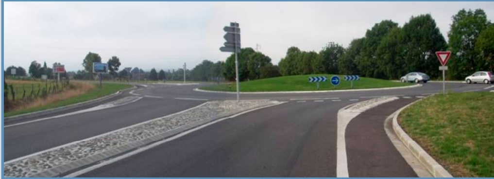
Caso francese - in caso di traffico pesante di grandi dimensioni scarso, e di grande flusso ciclabile, consente di realizzare corsie di sbocco per gli autoveicoli anche di dimensioni ridotte
