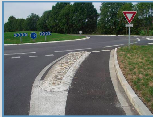
Caso francese - in caso di traffico pesante di grandi dimensioni scarso, e di grande flusso ciclabile, consente di realizzare corsie di sbocco per gli autoveicoli anche di dimensioni ridotte
