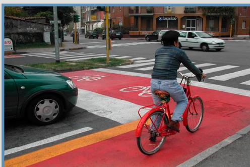
Per "casa avanzata" si intende lo spazio di attesa previsto davanti alla corsia degli autoveicoli nel quale le bici si attestano nella fase di rosso e in attesa del verde per poter partire davanti agli autoveicoli e godere di una situazione di maggior visibilità e sicurezza nell'effettuare l'attraversamento
