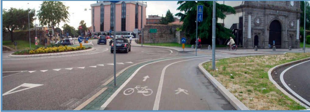
Padova, rotatoria con percorso esterno monodirezionale, tutti gli attraversamenti sono rialzati
