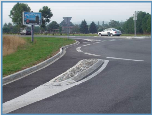
Caso francese - in caso di traffico pesante di grandi dimensioni scarso, e di grande flusso ciclabile, consente di realizzare corsie di sbocco per gli autoveicoli anche di dimensioni ridotte
