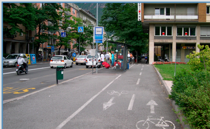
Bolzano, ottima soluzione per la fermata del Trasporto Pubblico, la bici passa lato interno ed i pedoni lato strada
