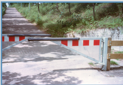
Doppia sbarra per impedimento transito automezzi
