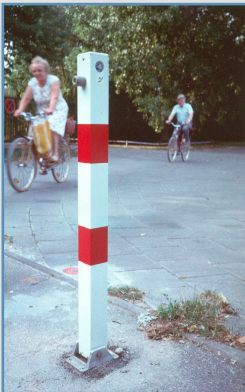
Esempio di paletto ribaltabile con chiave per l'accesso di mezzi per la manutenzione
