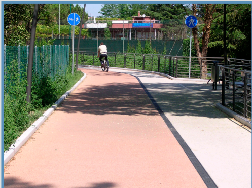
Mestre, parco villa Querini In ambito verde Ottima differenza di pavimentazione e elemento separatore a raso costituito da griglia drenante Migliorabile con segnaletica longitudinale di mezzaria per le biciclette
