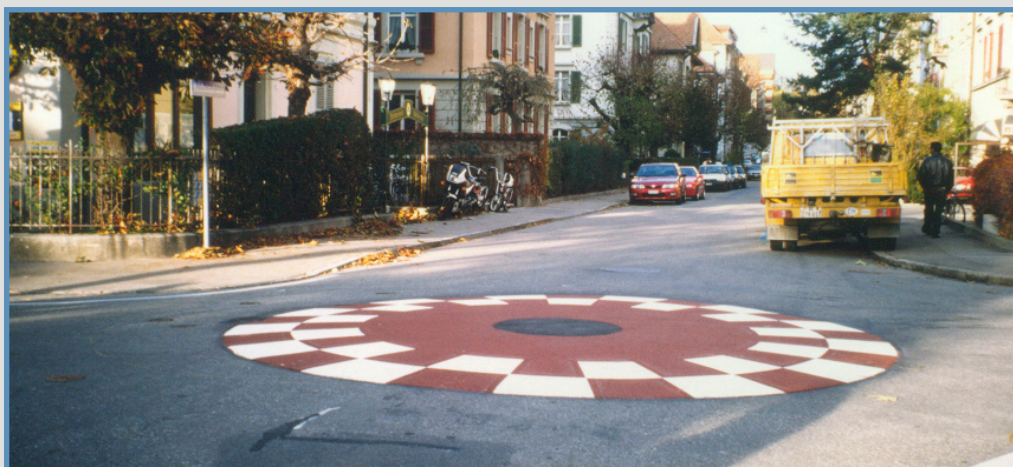
Intersezione con calotta di bitume
