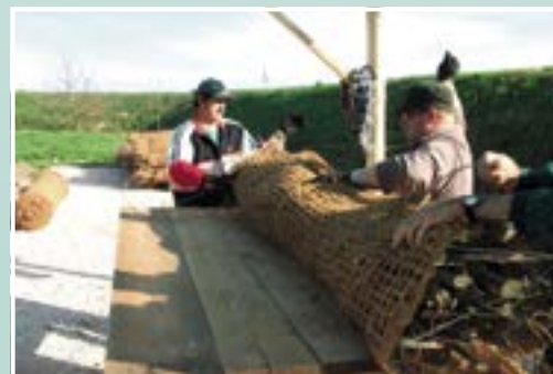
L'assemblaggio delle fascine con materiale ligneo di recupero
