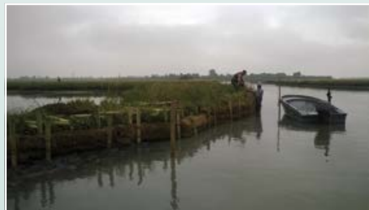
La gente del luogo realizza le protezioni con le fascine
