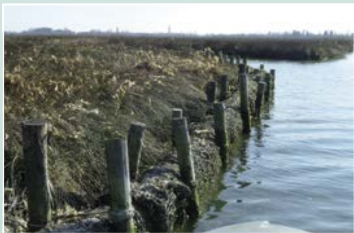
Fascine disposte a protezione della barena
