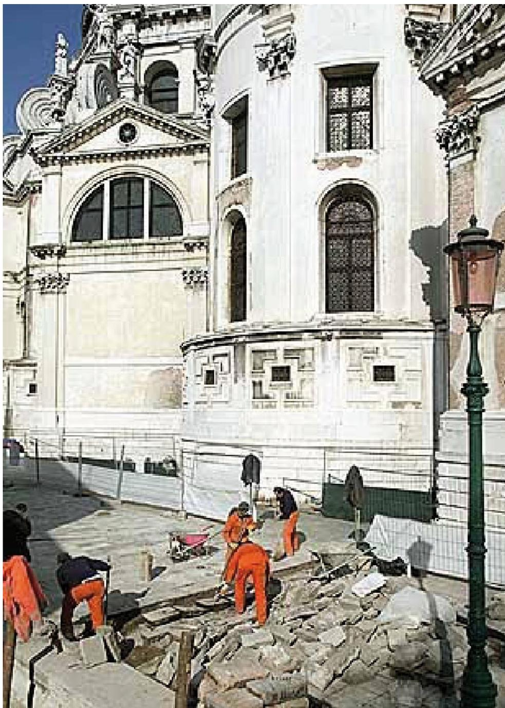
Il rio della Salute, dove sono stati restaurati i muri di sponda, rialzata la pavimentazione, risanato il sistema fognario, sostituite tutte le infrastrutture a rete (acqua, gas, energia elettrica, telefonia).
