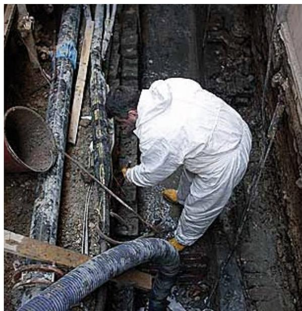
L'intervento di risanamento igienico sanitario ai Tolentini: sopra, lo stato delle fognature nella città storica; sotto, il cantiere per la ricostruzione e l'adeguamento dei collettori.
