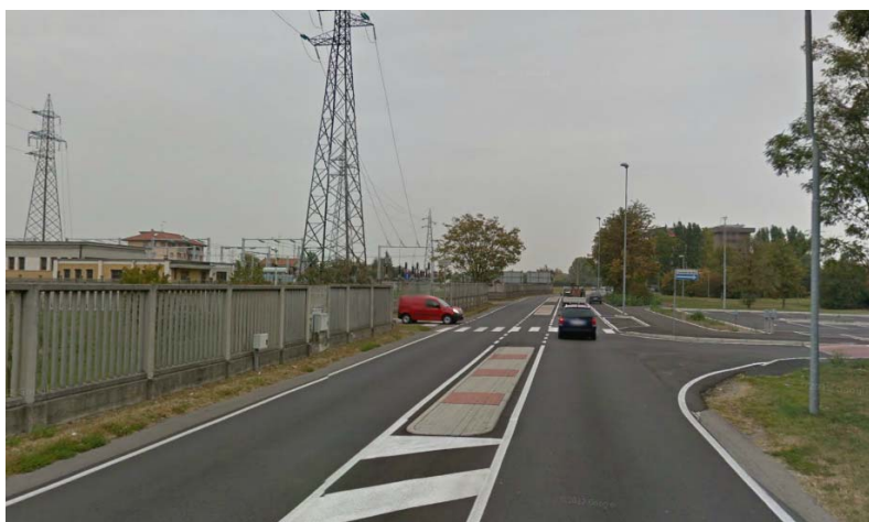
Esempi di elementi spartitraffico centrali sormontabili o non sormontabili
