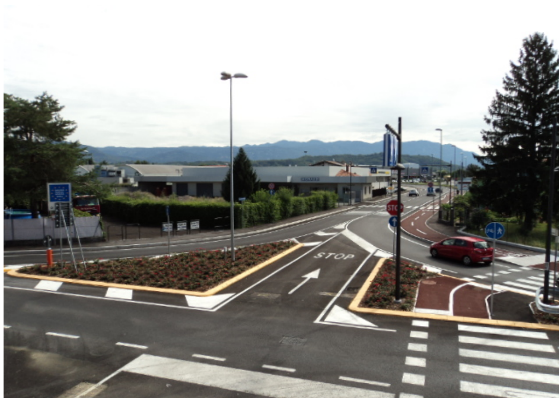
2° lotto - vista d'insieme dei lavori ultimati in via Trieste
