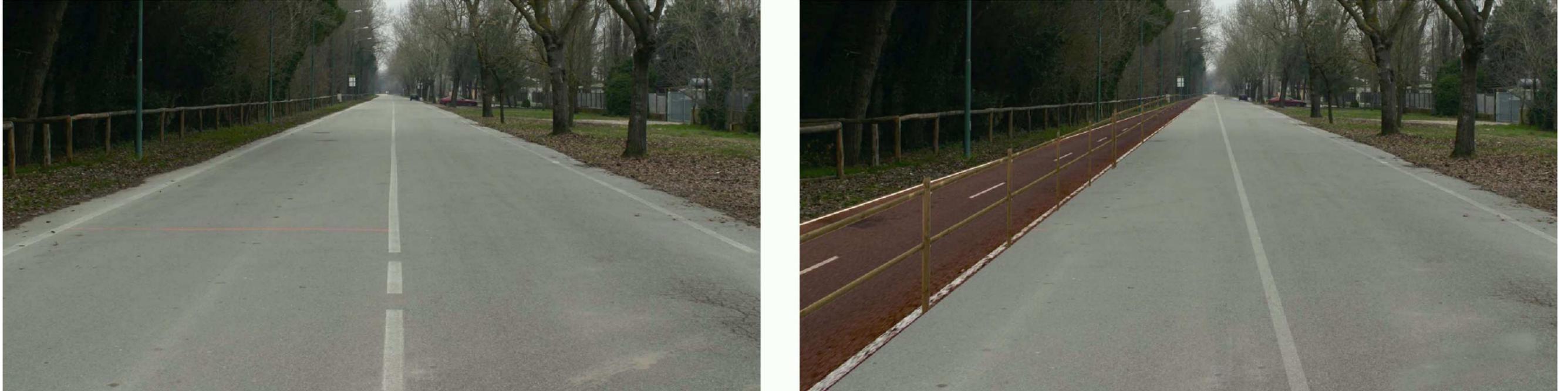
**2.3** - Da p.le Ravà all'inizio di lungomare D'Annunzio la pista si svilupperà come ciclopedonale bidirezionale in sede protetta, su rilevato in asfalto di larghezza 3,25 m separato dalla carreggiata mediante archetti in acciaio.
