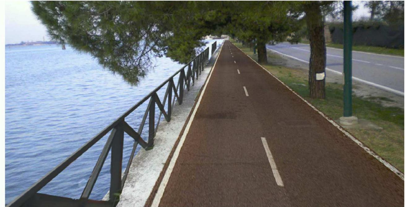
Per prevenire incidenti si dispone la realizzazione di un parapetto in acciaio verniciato che protegga ciclisti e pedoni da eventuali cadute in acqua. Anche in questo caso in località Malamocco e lungo via Alberoni, i canali che frammentano il fronte acqueo, verranno superati da apposite passerelle ciclabili ancorate al fianco dei ponti carrabili esistenti.
