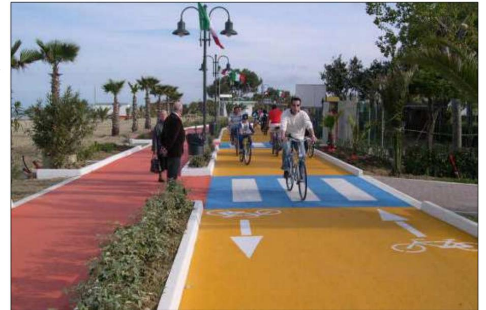
Foto 11: esempio di pista ciclabile in sede propria in area balneare con separazione dal traffico pedonale
